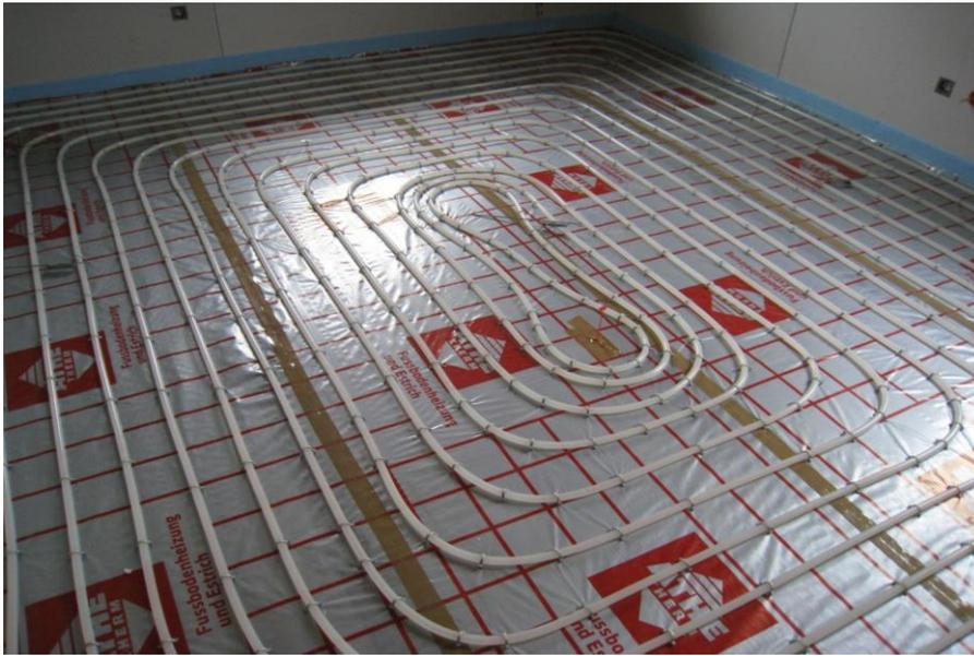
Die hier verlegte Fußbodenheizung ist optimal verlegt. Eine gleichmäßige Trocknung und Beheizung der Estrichfläche ist garantiert. Das Rissrisiko gering. Das ist eine tolle Arbeit des Heizungsbauers.
