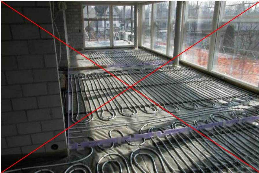
Die Bodenheizung sollte möglichst in „Schneckenform“ verlegt werden.
