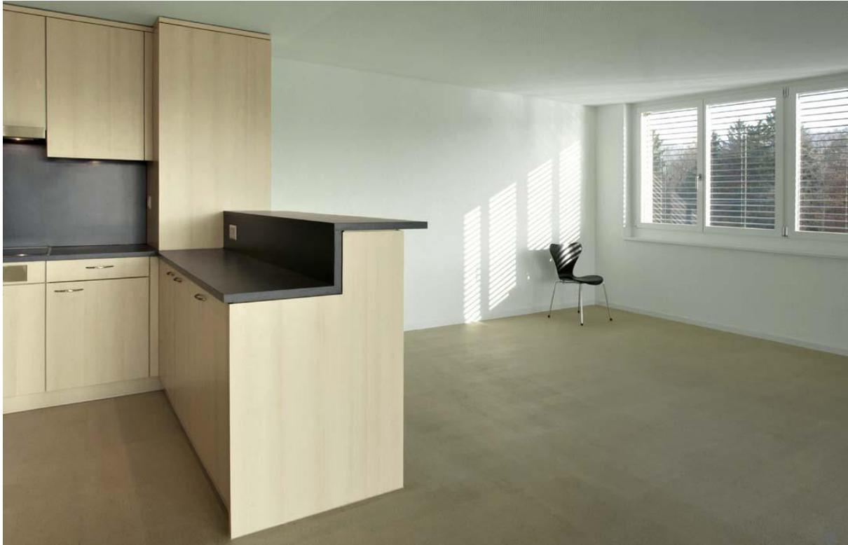
Versiegelte Böden aus calciumsulfatgebundenen Fliessestrichen erfreuen sich immer grösserer Beliebtheit. Der Anteil dieser Dekorböden ist in den letzten Jahren gestiegen. Die Estriche sind als Fertigbelag im nichtindustriellen Bereich geeignet. Das Bauteil wird direkt als ästhetisches Mittel eingesetzt.
