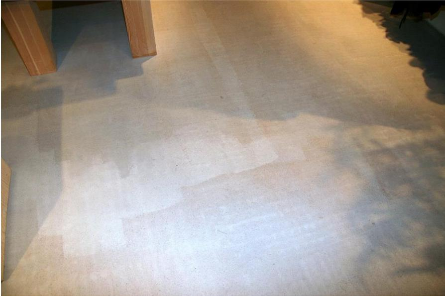
Rollerspuren können nur mechanisch (schleifen) entfernt werden. Nach dem Schleifen ist ein erneutes Versiegeln oder Ölen notwendig. Grundsätzlich müssen Rollerspuren akzeptiert werden können, dieselben sind nicht vermeidbar.
