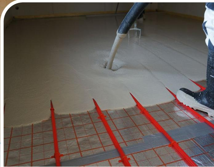
Ideal für Heizestrüche dank geringer Einbaudicke, guter Wärmeleitfähigkeit und sauber umschlossenen Heizrohren. Bereits nach 30 Minuten ist ein deutlicher Temperaturanstieg messbar.
