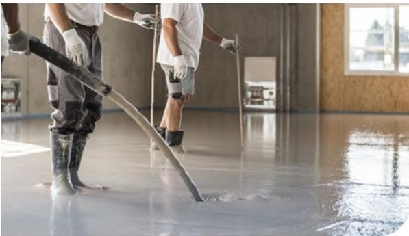
Aufbau\* mit 55 mm Calciumsulfat-Fliessestrich:
