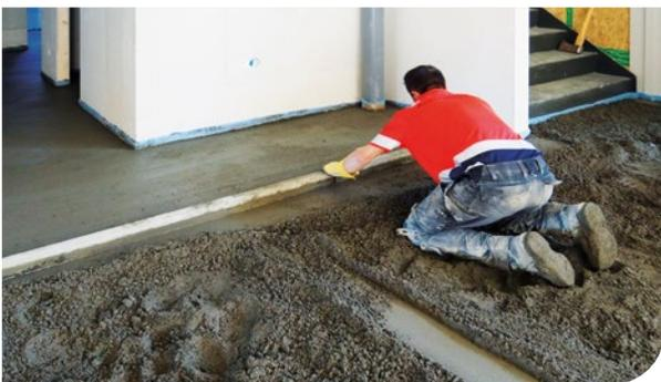
Aufbau\* mit 80 mm Zementestrich:
