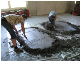
La plaque prototype peut p.ex. être marquée et „découpée“ avec la truelle à joints.
