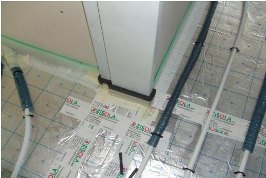
Les chambranles de porte doivent être enveloppés en suivant leur forme afin d'éviter des arrondis.
