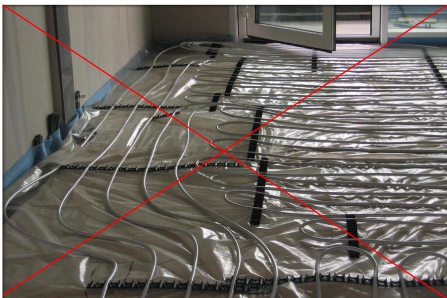
Les différents circuits de chauffage doivent être séparés au moyen de joints de dilatation. Les circuits de chauffage doivent être «adaptés» aux joints.
